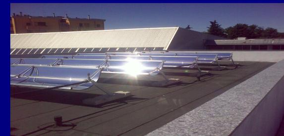
I moduli SolarWing Evolution sono costituiti da un collettore solare con trattamento superficiale ad altissimo assorbimento protetto da tubi sottovuoto che evitano la dispersione del calore in atmosfera, il tutto posto nel fuoco di un concentratore solare speculare trilobare ad elevato grado di riflettanza (maggiore del 95%) che convoglia l'energia solare verso il collettore stesso consentendo di raggiungere temperature elevate.
